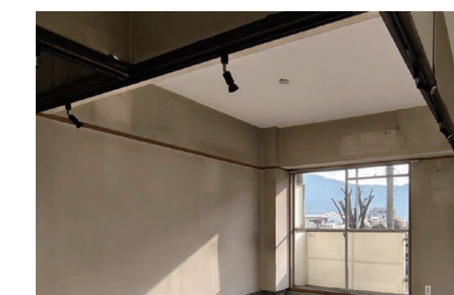
既存の垂れ壁は電気レールの敷設に利用した。
