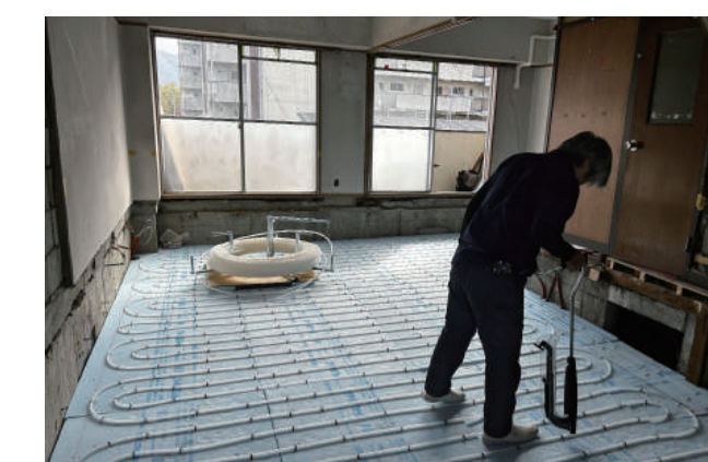
床暖房敷設時の写真。パイプの中を温水が通る。
