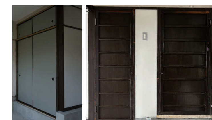
既存の要素を活かすため、既存の建具や古建具を使用した。
