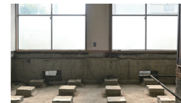
床解体後の写真。床の束石は磁石層に利用した。
