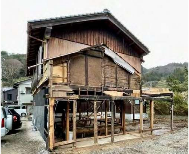
伊根町内の主屋の改修に合わせて解体された下屋
