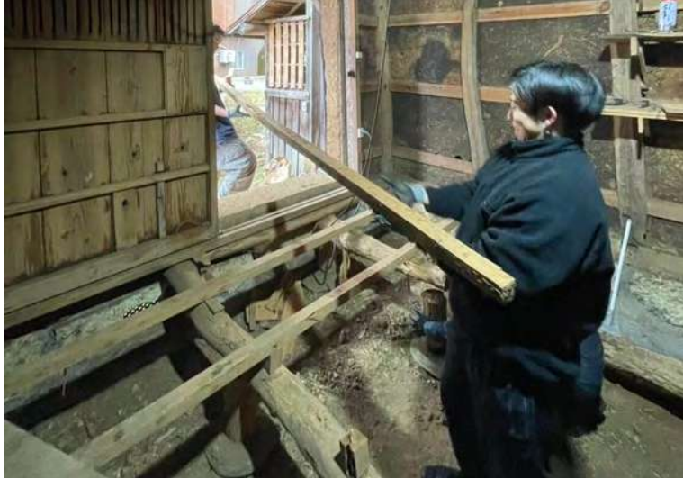
1階既存床の一部撤去し、縁側を内部に創出
