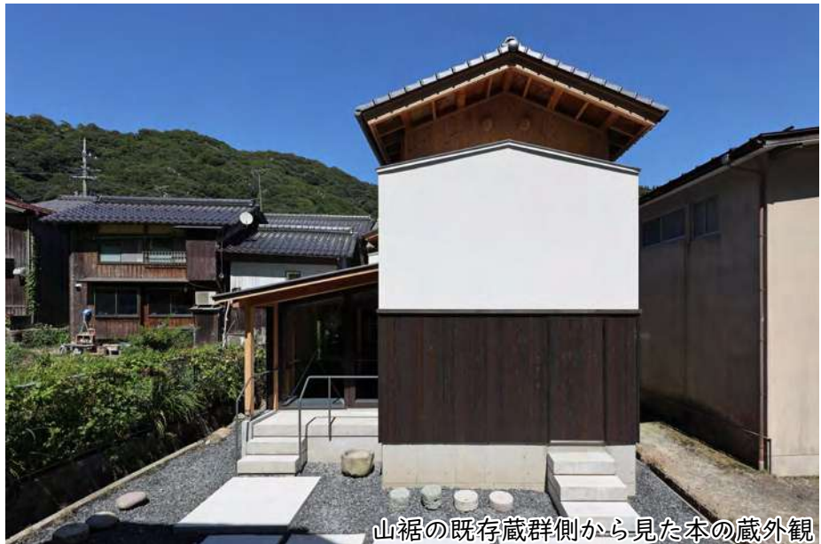
山裾の既存蔵群側から見た本の蔵外観
