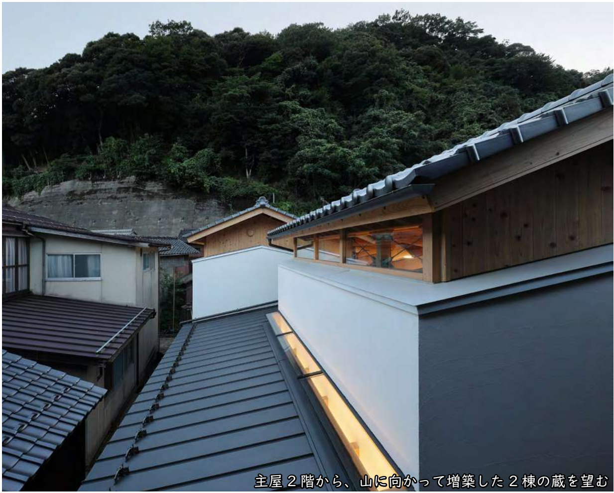
主屋2階から、山に向かって増築した2棟の蔵を望む
