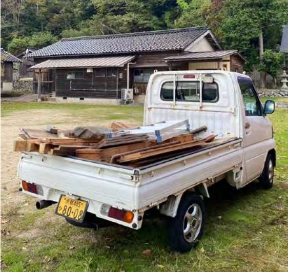
解体建物・空き家から古材を改修
