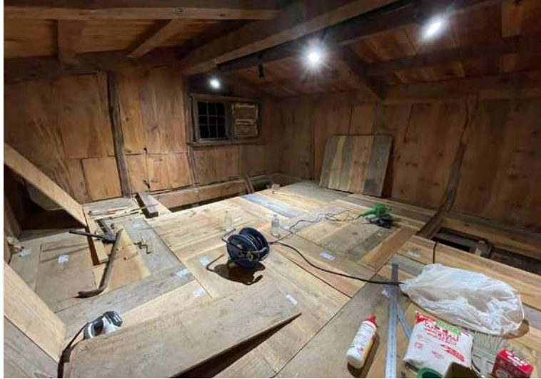
古材を活用して2階床を貼り換え補強
