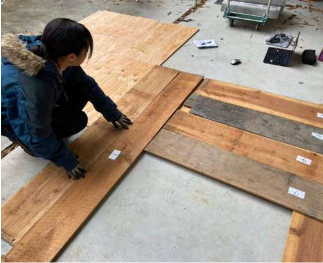
大学での作業、運搬を考慮して半間ごとにユニット化
