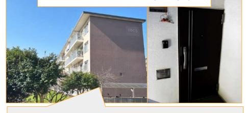
建て替えではなく改修で「100年もつ団地」を目指している竹山 16-2 ブロック。2010・2011年に全ての建物全体の外断熱工事と、 全住戸の窓サッシをペアガラスに交換しています。その際のエコ ポイントを活用し、玄関ドア・床下断熱の改修も実施しました。 その結果、住民からは「真冬の朝でも室温は17度で快適」と評 判です。
