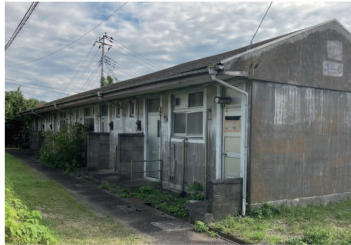
構造は壁がコンクリートブロック造、屋根架構は木造でできている。
